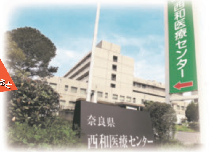
病院前道路からのview
