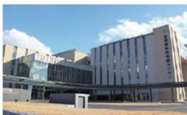
奈良県総合医療センター
