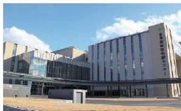
奈良県総合医療センター
